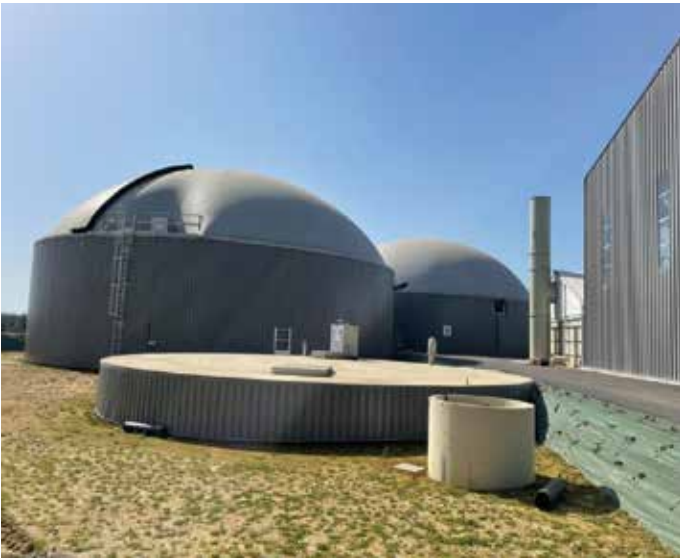
Photographie d'un méthaniseur dans le département du Maine-et-Loire.
