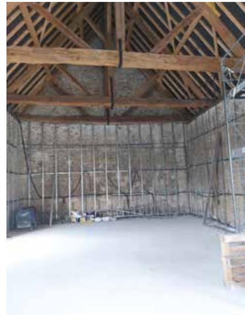
Pose des menuiseries dans les ouvertures pour le côté cour sur cette photo et isolation des parois intérieures
