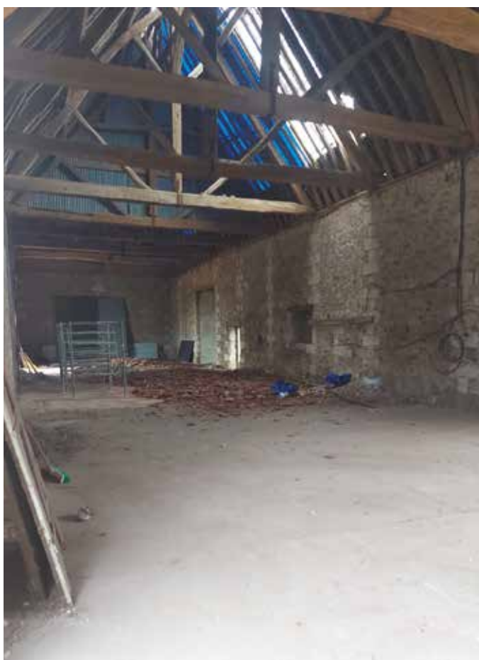
Intérieur de la Grande Ferme : on va démonter la toiture
