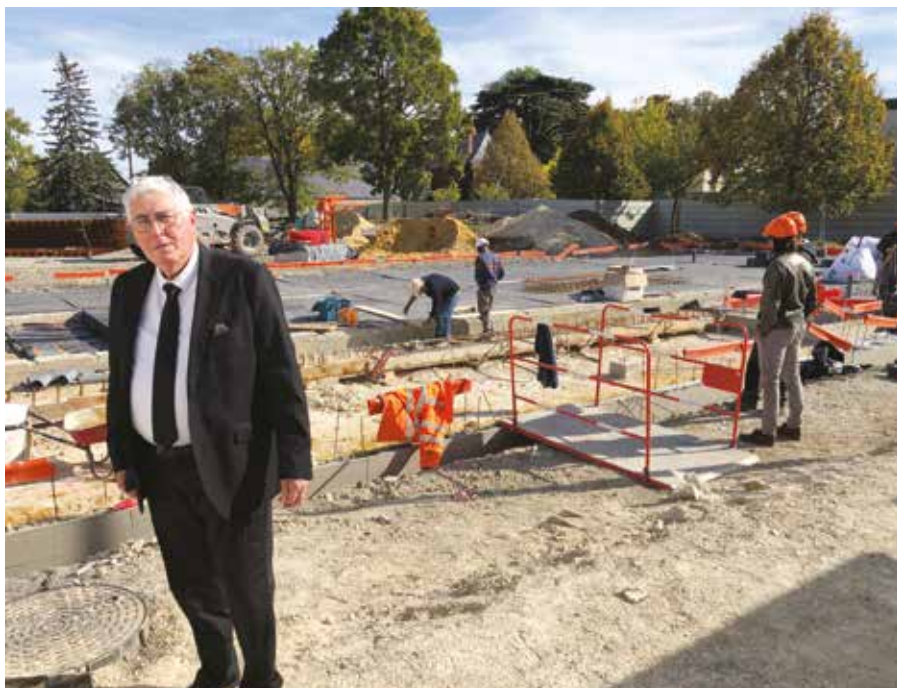
Réunion de chantier le 16 octobre, ça avance bien !
