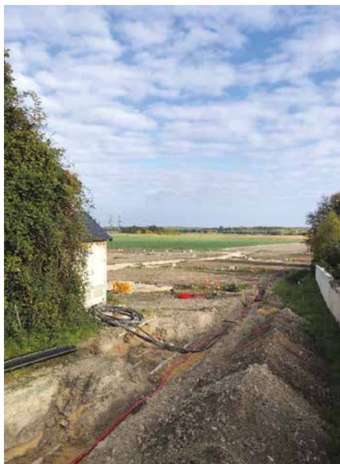
Chantier de la ZAC Nord, derrière la Mairie
